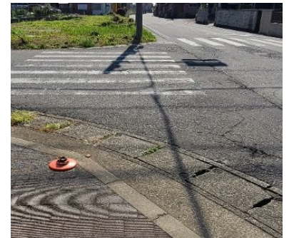
R7-7 ポール・外側線等の修繕
