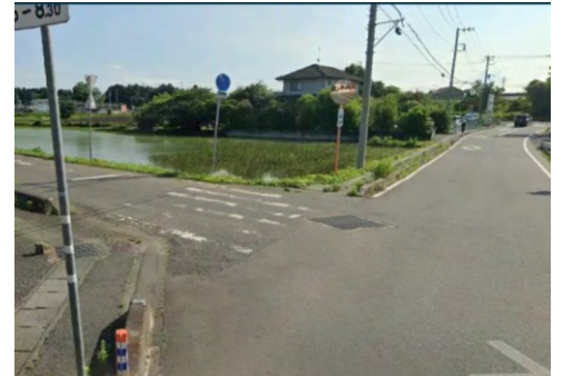
R7-13 横断歩道の塗装が薄れている
