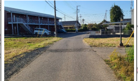
R7-1 大雨時に冠水する
