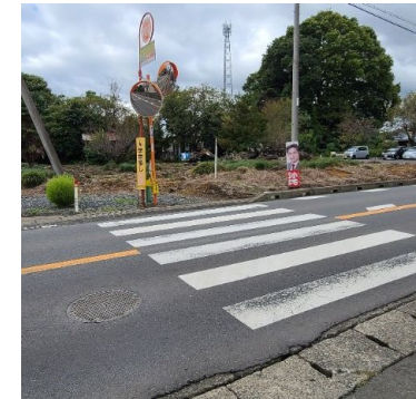
R7-17 交通量の多い横断歩道
