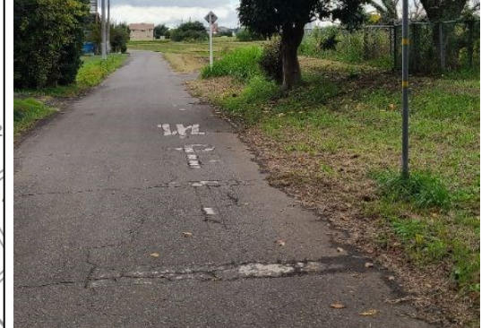
R7-18 一時停止線の補修
