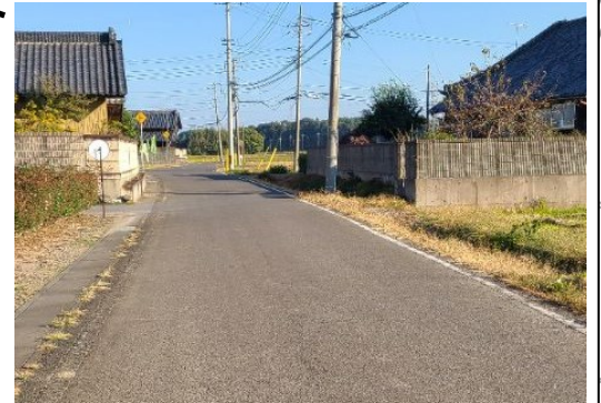
R7-2 外側線等の修繕
