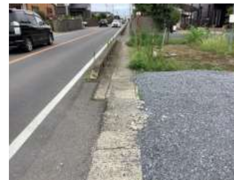
R4-18 段差のある歩道
