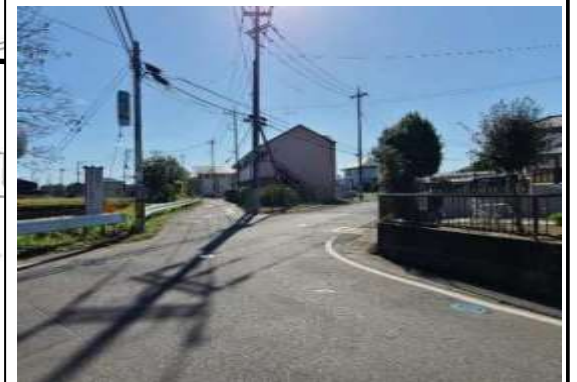
R6-8 道幅が狭く交通量の多い交差点
