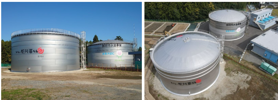
▲完成したステンレス製配水池配水池(手前が2号配水池) 容量：3,500m 3 /基 × 2基 = 7,000m 3
