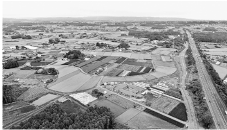
那珂インターチェンジ周辺
