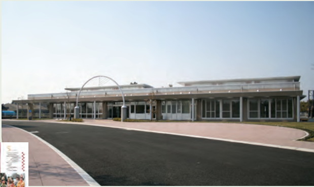
▲ふれあいセンターよこぼり竣工式 (平成17年3月28日)
