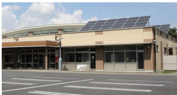
「ふれあいセンターごだい」太陽光発電設備
