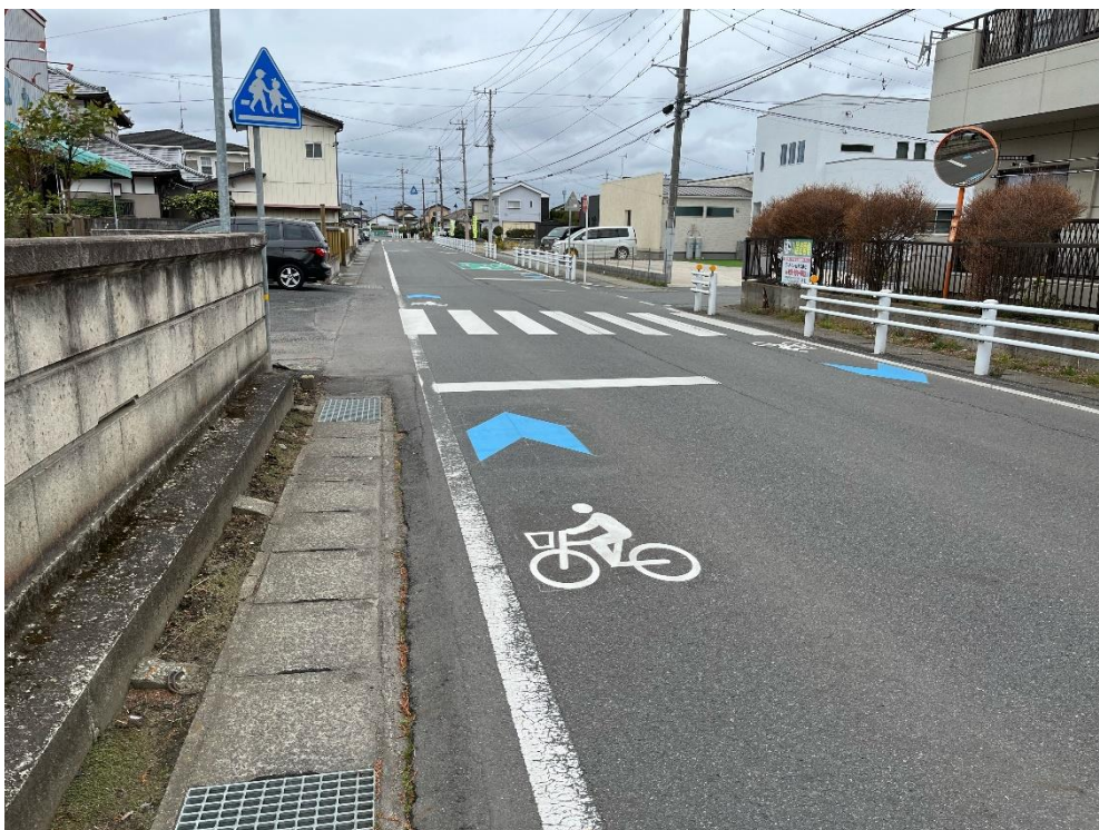
③市道6-0014号線（菅谷小学校付近）
