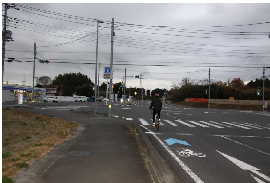
整備箇所の写真
