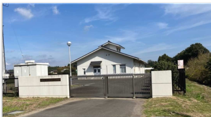
鴻巣地区農業集落排水処理施設
