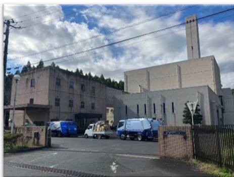
大宮地方環境整備組合環境センター
