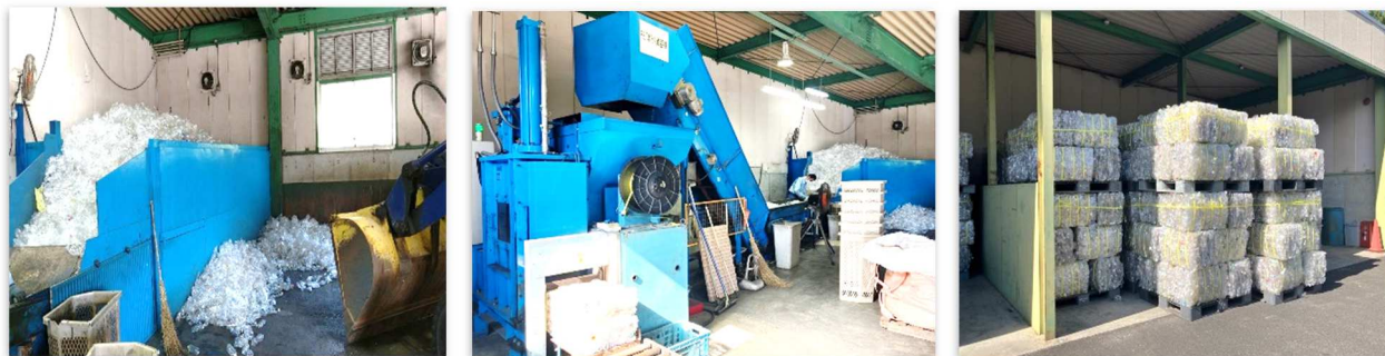
環境センター粗大ごみ処理施設でのペットボトル処理
