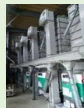
穀類乾燥調製施設 (ライスセンター)
