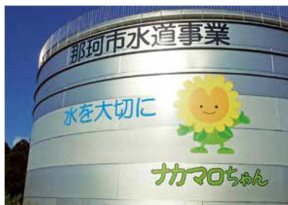
木崎浄水場配水池
