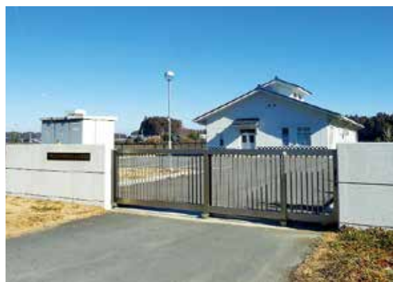
鴻巣地区農業集落排水処理施設
