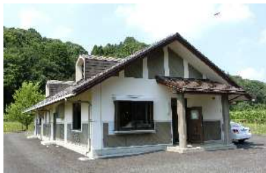
戸多北部地区処理施設
