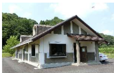
戸多北部地区処理施設
