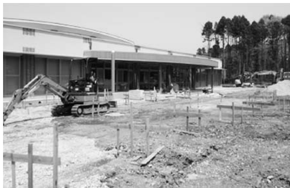
建設中の一中学区コミュニティセンター
