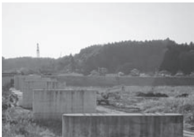
建設中の城里那珂線の架橋(戸多地区)
