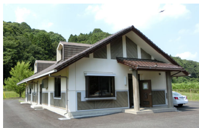
戸多北部地区処理施設
