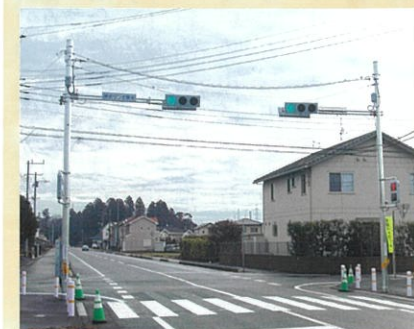
信号機が新設された横断歩道
