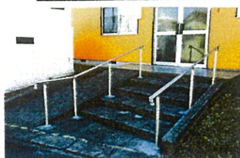
設置した手摺り前景
