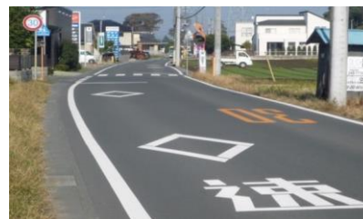
H29-2 交通量が多く、道幅が狭い
