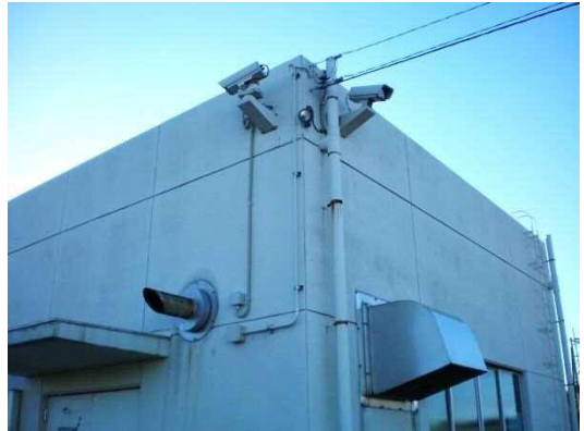
写真 5-4 後台浄水場の監視カメラの設置状況
