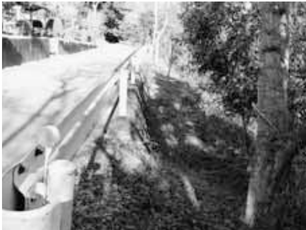
▲急傾斜地崩壊危険箇所（本米崎地区）
