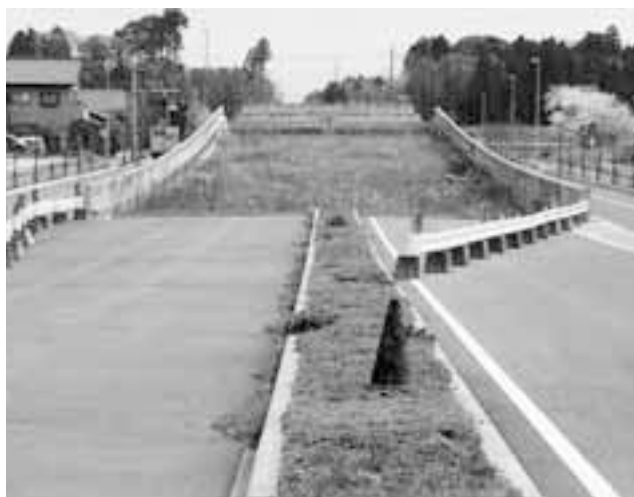
▲建設中の菅谷飯田線 (国道6号と国道118号を結びます)
