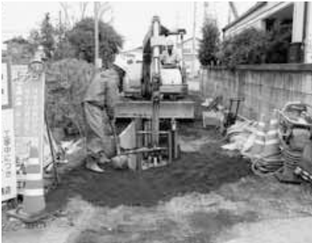
▲下水道工事（菅谷の杉原地区）
