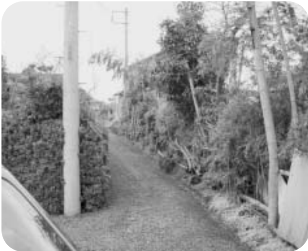
緊急自動車の進入もできない未整備生活道路
