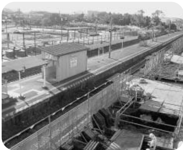
工事中の瓜連駅
