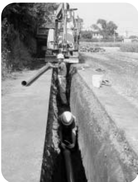
水道工事(中台地区)
