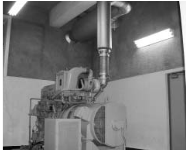
木崎浄水場のポンプ室
