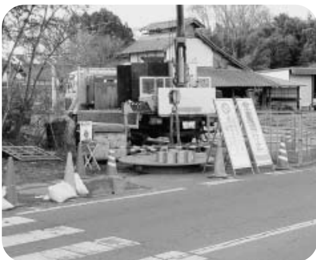
下水道工事(横堀地区)
