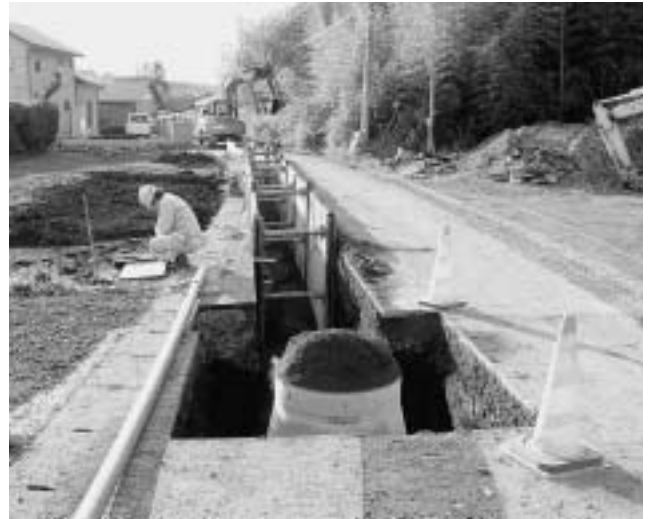
下水道工事(中里地区)
