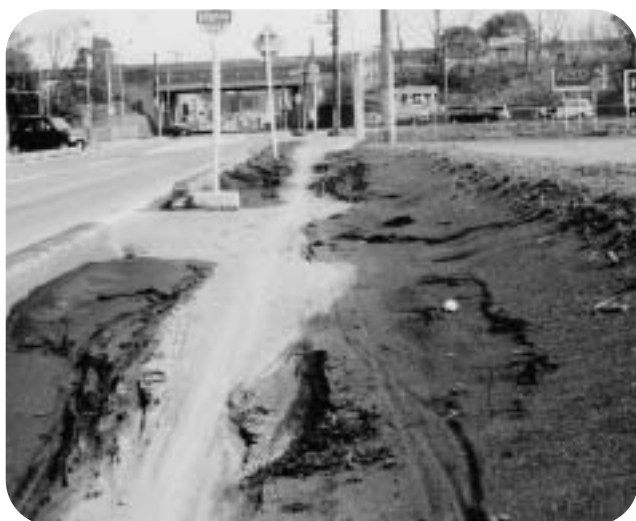
くわどめ(土留め)がなく、土砂が歩道へ
