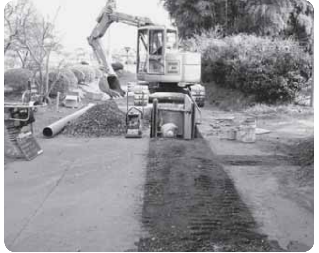
下水道工事（横堀地区）
