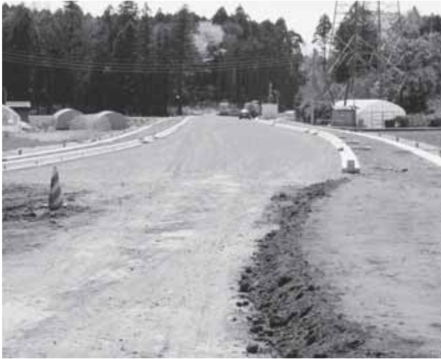
道路工事（菅谷地区）
