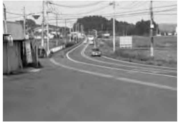
▲4車線化の早期整備を 国道118号線（下大賀地区）
