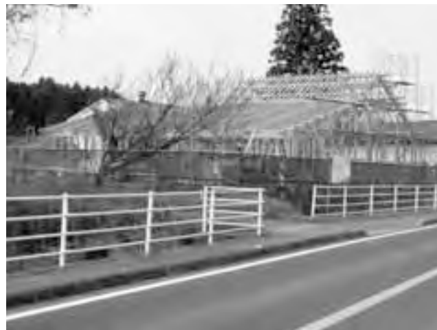
▲建設中の芳野物産直売所（鴻巣地区）
