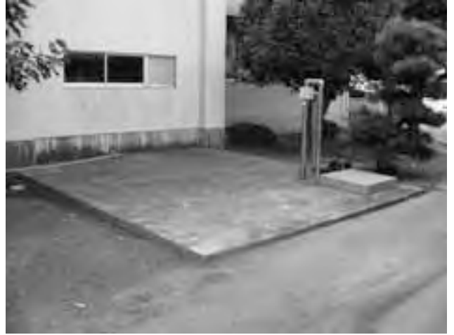
▲芳野小学校の地下受水槽
