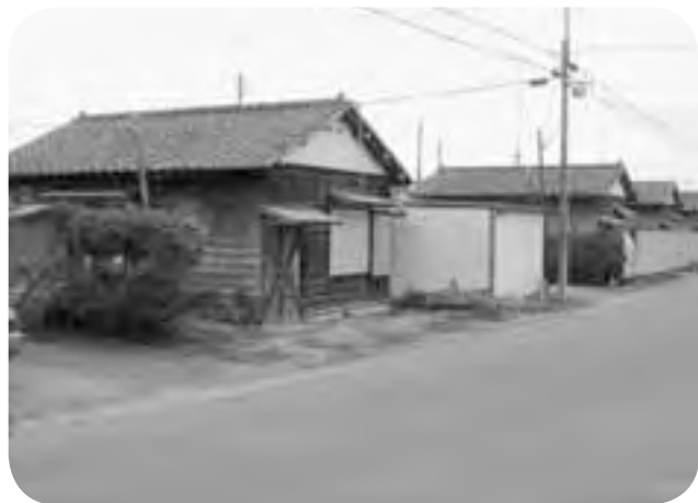
▲老朽化している市営茨野住宅（後台地区）
