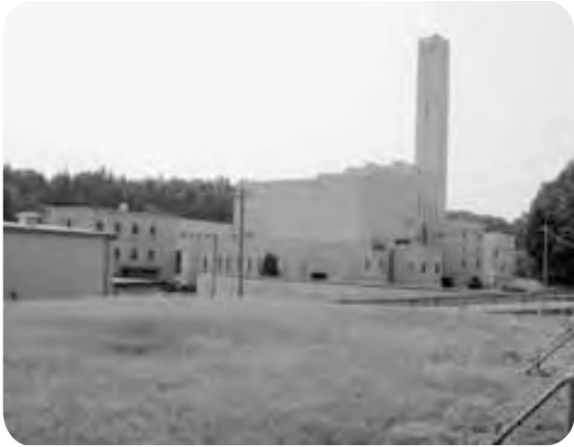
▲大宮地方環境整備組合 環境センター（静地区）
