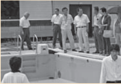
学校のプールの被害状況を視察
