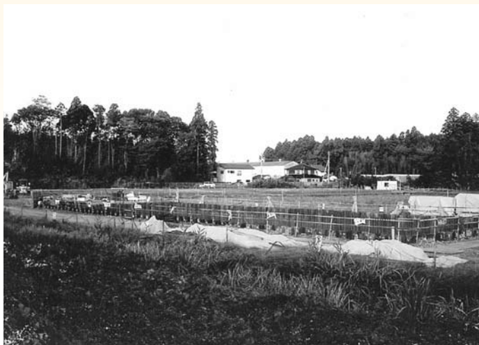
鴻巣地区農業集落排水終末処理場建設現場
