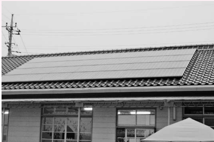
太陽光発電の設置
