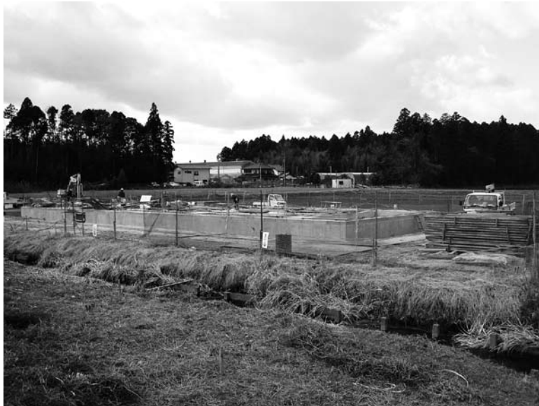
建設中の鴻巣地区農業集落排水処理施設
