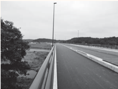
平成26年10月22日開通の那珂西大橋
