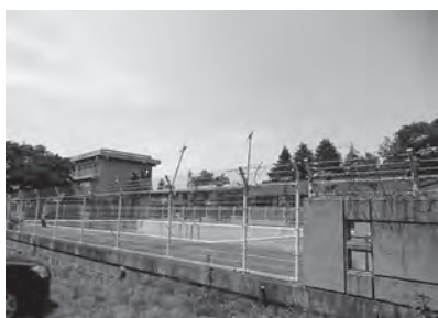
第三中学校 危険防止のため有刺鉄線等が設置されている。
