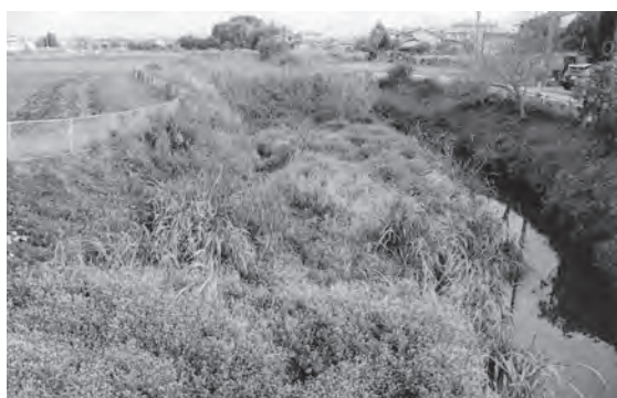
堆積した土砂に繁茂した雑草
