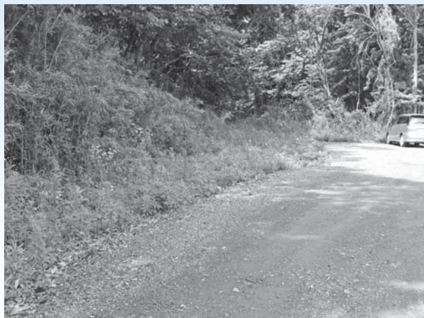
年内工事完了予定の向山大山2号線
