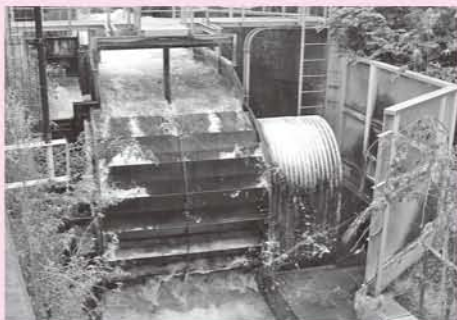
家中川小水力発電所「元気くん2号」
