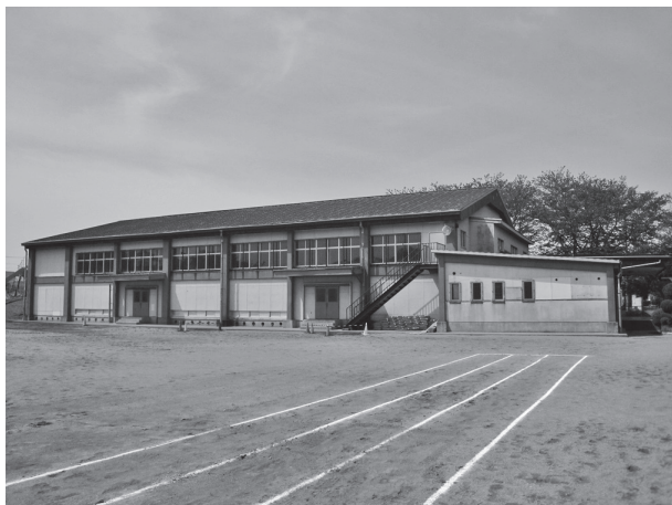
那珂市立額田小学校の屋内運動場
