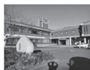
那珂市役所瓜連支所 築後27年
