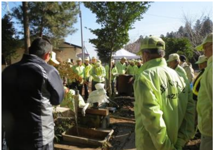
発電機による自動給水と手動井戸ポンプの復旧完了
