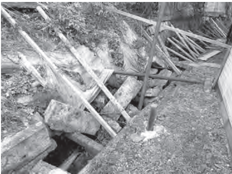
崩れてゆく宅地の擁壁
