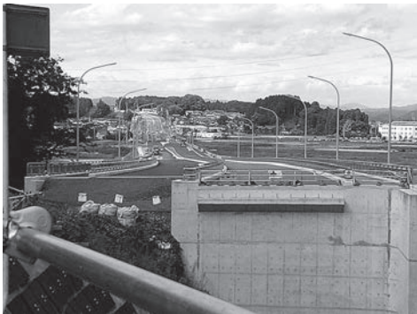
建設中の国道118号線下大賀坂下付近
