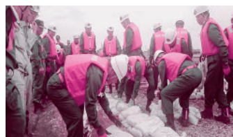
積土のう工法
