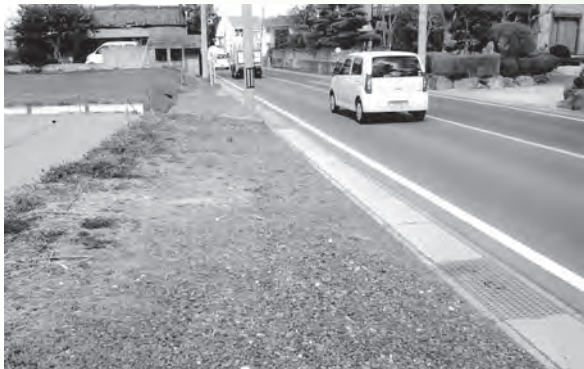
旧国道349号線の並木敷
