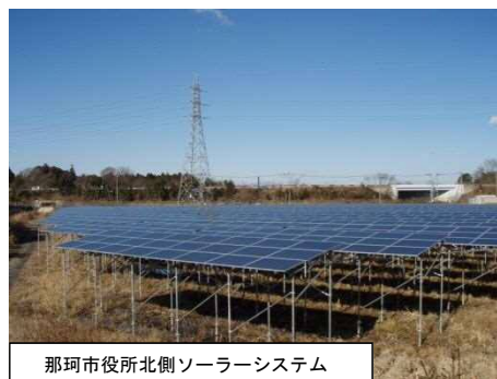
那珂市役所北側ソーラーシステム
