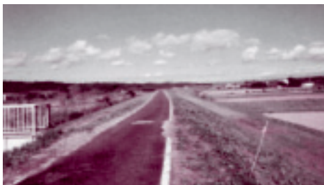
▲改修された那珂川堤防と河川敷
