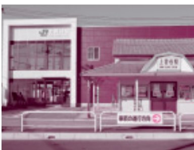
◆新築された上菅谷駅舎と旧駅舎
