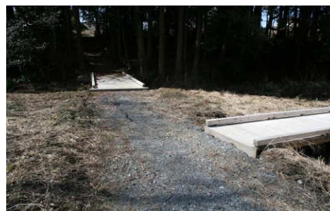
震災後の清水洞の上公園
