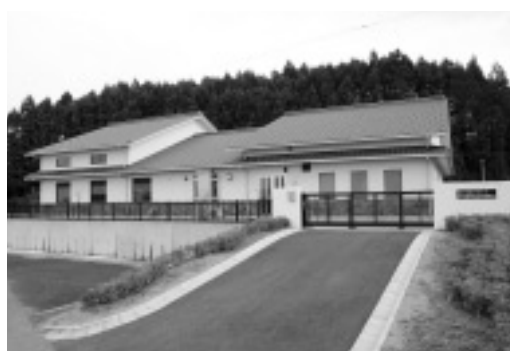
◆生活排水処理の普及促進に、引き続き努めていきます。(神崎額田地区 農業集落排水処理施設)
