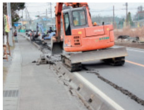
■復旧に向けて道路の亀裂・陥没を修理
